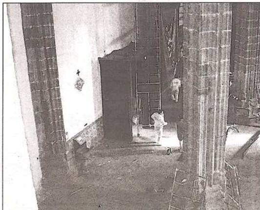
Trabajos en el interior del templo parroquial / LACABA
