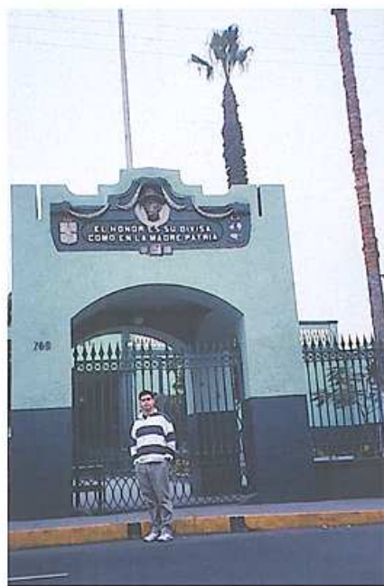
Fachada de un antiguo Cuartel de la Guardia Civil del Perú
